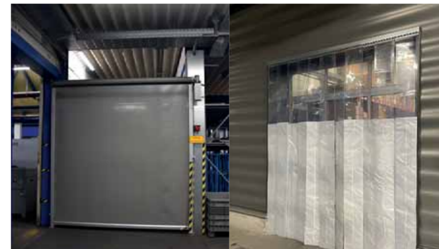
Nello spirito della sostenibilità, sono state implementate misure di risparmio energetico nei siti. A Gmunden è stata installata una porta automatica ad alta velocità con sensore. A Büron, due nuove tende (magazzino e produzione) offrono una maggiore protezione dal freddo.
