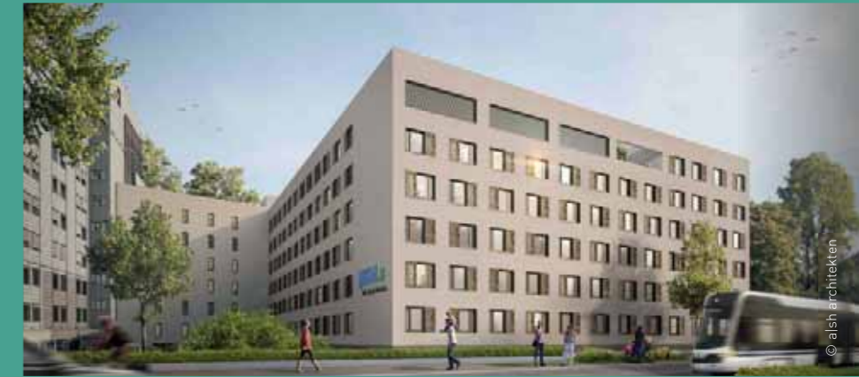
→ Klinikum Ludwigshafen Ludwigshafen, DE Swing, protezione antincendio F30/I30
