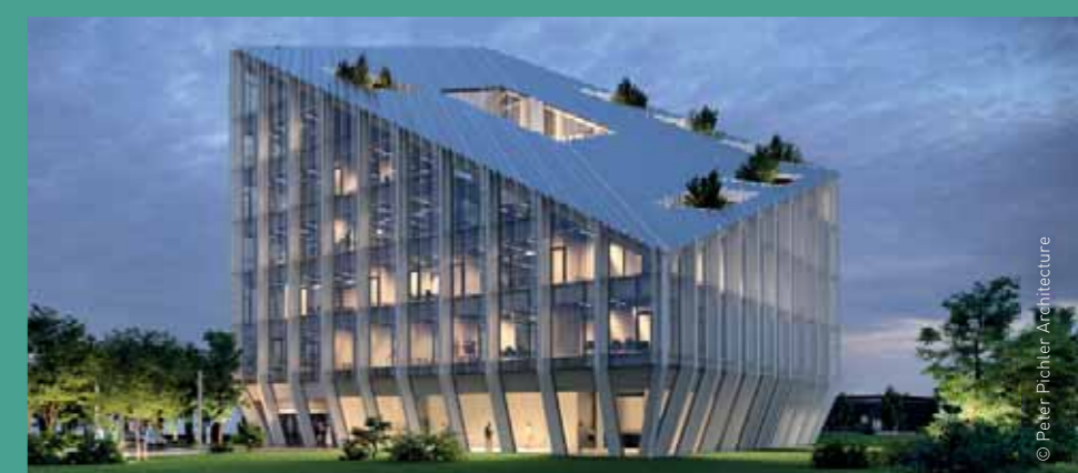
→ EVO Plant Bonfiglioli Headquarter Bologna, IT Controsoffitti radianti
