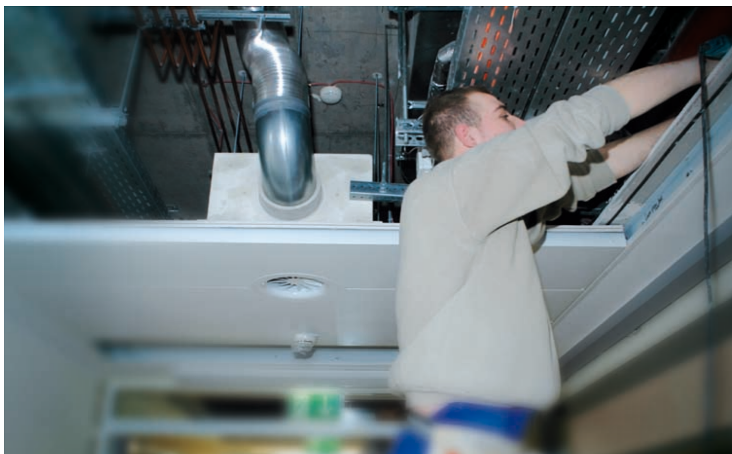
allacciamento ventilazione EI 30
